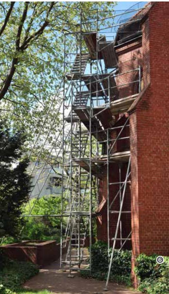
Während wir noch mitten in der Freude der Osterzeit schwelgten, rückten, da es wärmer wurde, die Handwerker an und errichteten ein hohes Gerüst ⑥ an der Außenfassade und zwei kleinere im Altarraum und auf einer der Emporen von St. Afra. Die Gerüstbauer waren aber nur die Vorboten der Kunstglaserei Wilde aus Tangerhütte, die nun in einem weiteren Bauabschnitt die Bleiverglasung der Marienkapelle renovierte. Einen ausführlichen Bildbericht finden Sie ab Seite 14.
